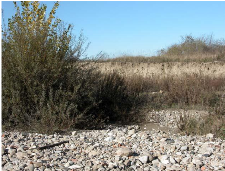
Zona di pronunciata erosione
